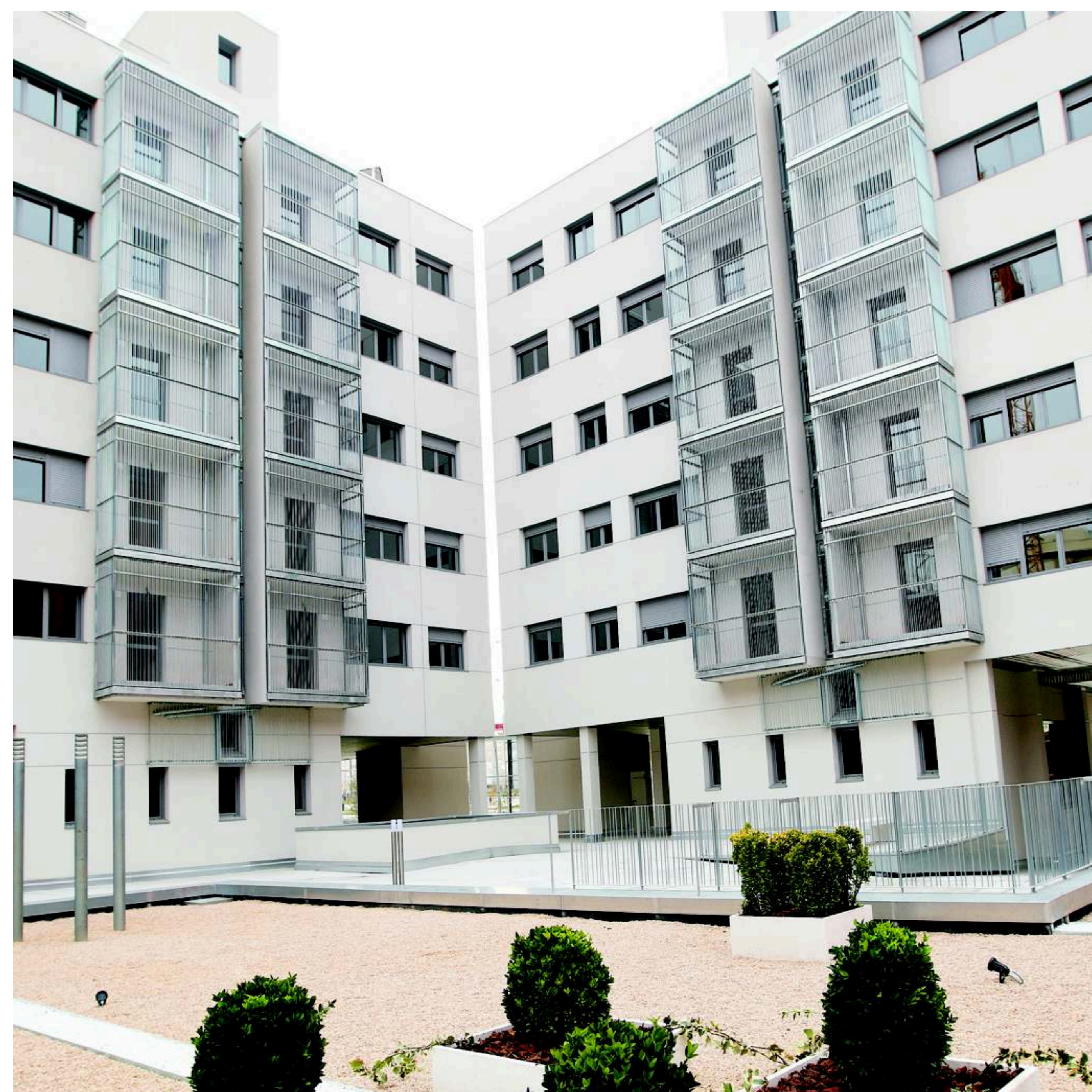
Zona terraza con arbustos en el espacio común interior
